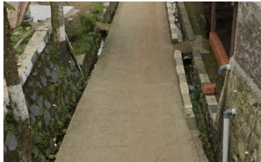
Gambar 1 Perkerasan Kaku Eksisting
