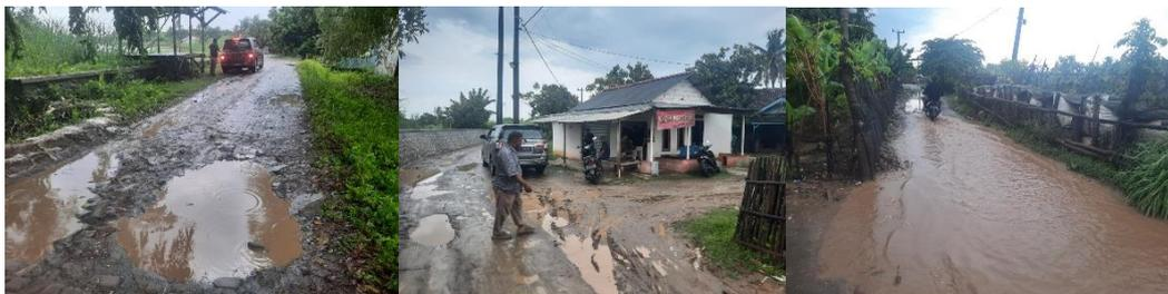
Gambar 5 Kondisi Perkerasan Paving Block di Jl. Pantai Bahagia
